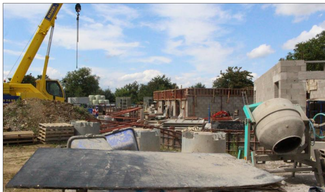
Les travaux du futur accueil périscolaire intercommunal de Spechbach ont démarré en début d'année 2021, à côté de la salle polyvalente. Ouverture prévue à la rentrée 2022. Photo L'Alsace/V.M.
