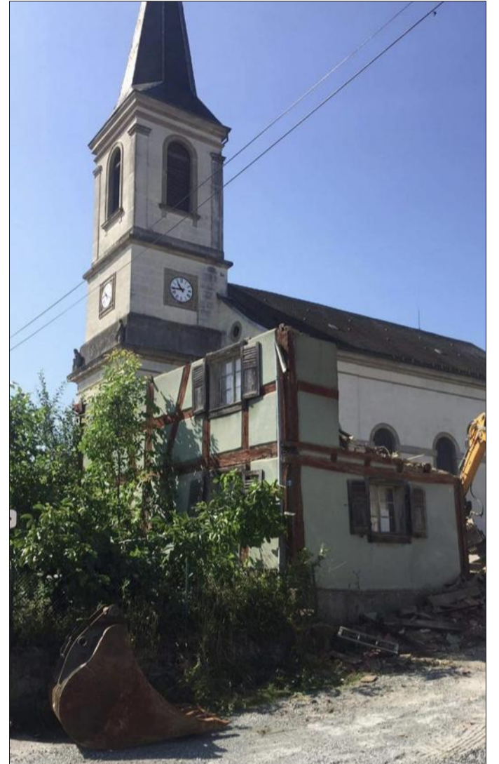
Rachetée par la commune en 2014 et inoccupée depuis les années 1980, la maison verte démolie le lundi 19 juillet était l'une des plus anciennes maisons à colombages de Spechbach. Une destruction qui ne passe pas à l'Association pour la sauvegarde de la maison alsacienne (Asma). DR
